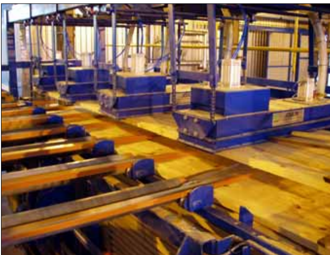
3. Lagenentstapelung, quer ablaufend, mittels Vakuumheber
